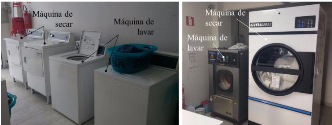
Figura 3 – Máquinas de lavar e de secar com capacidade de 10 kg e 17 kg.
